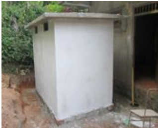
汚水処理付きトイレ建設
