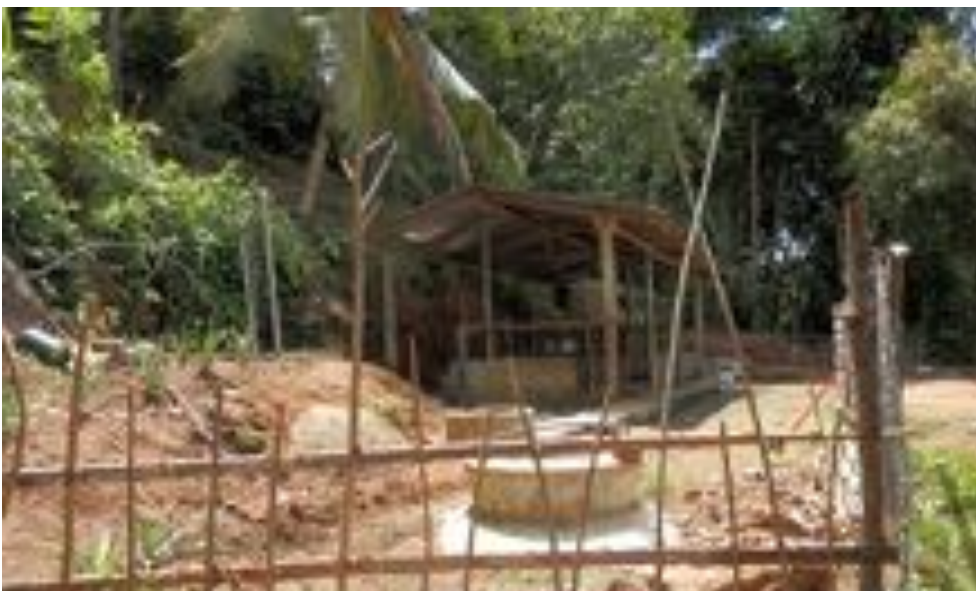
写真中央が牛舎、左の鉄パイプがガス導線、手前のマンホールの地下にバイオガス発生タンク
